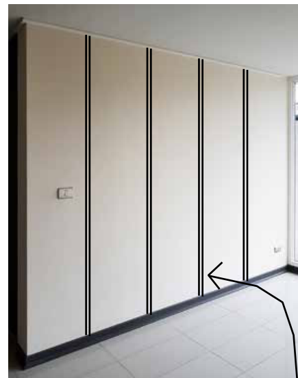
Ubicación de la estructura del tabique
